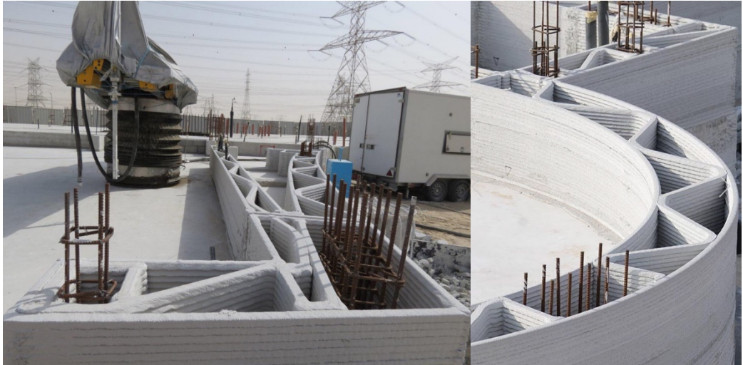
Figur 2.4 Exempel på 3D-printat hus i Dubai. Färdigprintad byggnad samt foton från printprocessen. Från [16]
