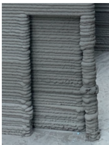
Figur 3.13 Visar en öppning där det går att fästa ett installationsskåp för tex golvvärme eller vatten.
