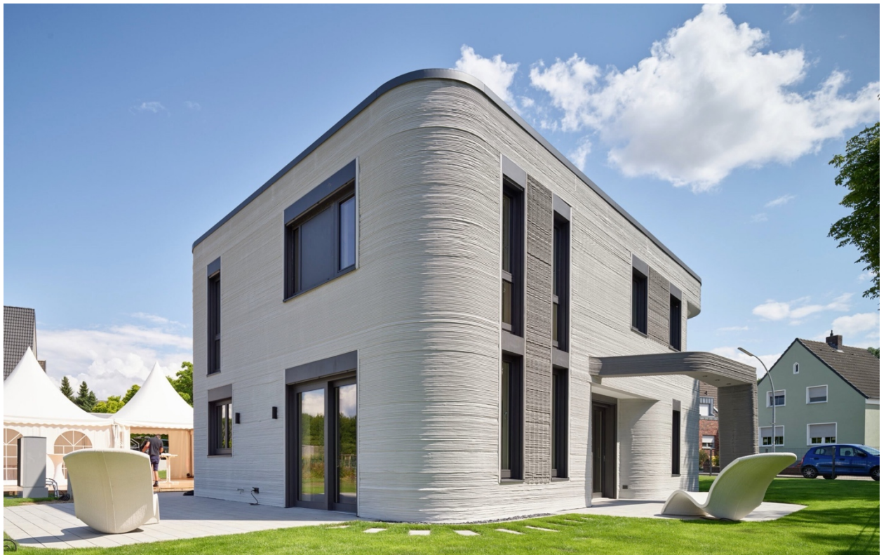
Figur 2.5 Foto på 3D-utskrivet hus i Beckum, Tyskland. Från [17]
