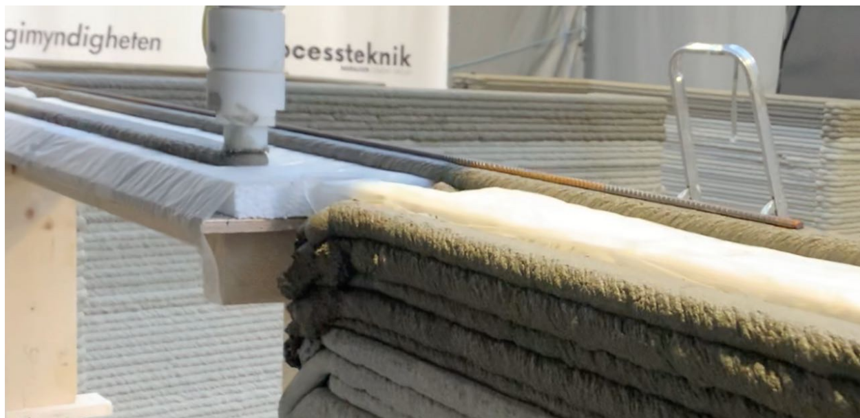
Figur 3.29 3D-printing på monteringsstöd över öppning samt förstärkning med armering. Notera att stödet som har placerats under öppningen har försetts med cellplast och plastfolie, vilket underlättar vid demontering.
