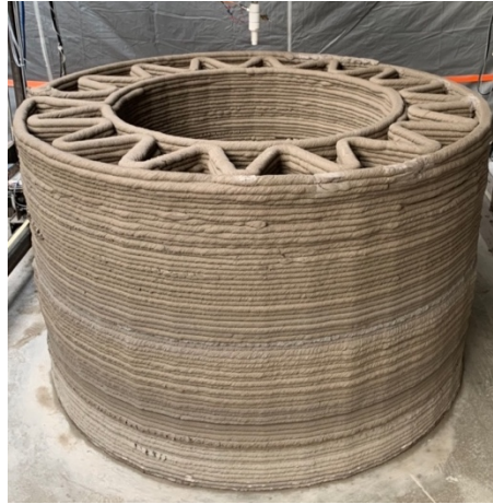
Figur 3.1 Visar ConcretePrints 2 meter i diameter 3D-printde cylinder från våren 2020. Resultatet var mycket låvande men utmaningar fanns, tex går det att se på cylindern att på de övre lagren är kvalitén på det printade något ojämnt.
