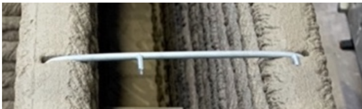
Figur 3.6 Detalj på väggtyp b) i Figur 3.5 med stålstång som förbinder inner och yttrevägg.
