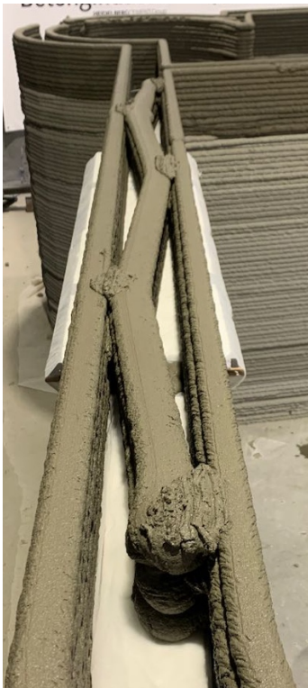
Figur 3.28 Balk som skapat vid 3D-utskriften som förstärkning vid större öppningar. Zig-zag metoden används. Armeringsjärn är inplacerade, se Figur 3.29.
