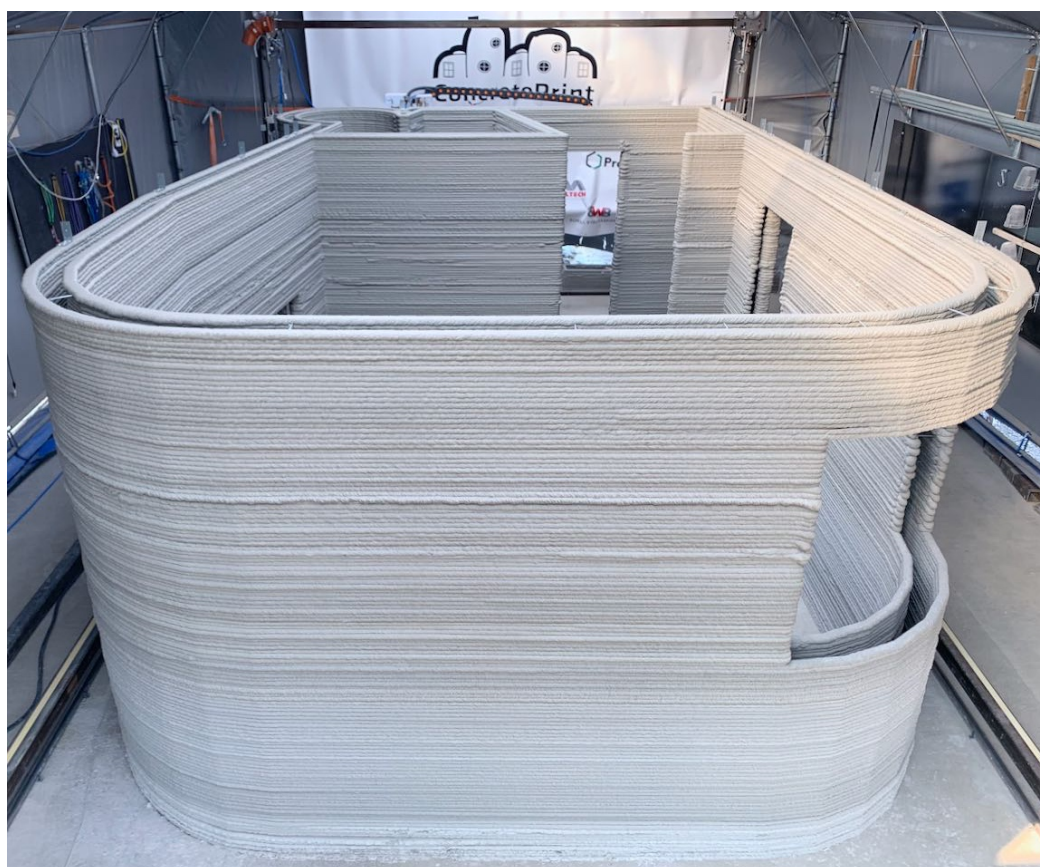
Figur 3.30 Visar den färdiga stommen från den 18 juni. Själva utskriftsarbetet har då pågått i under 13 arbetsdagar.
