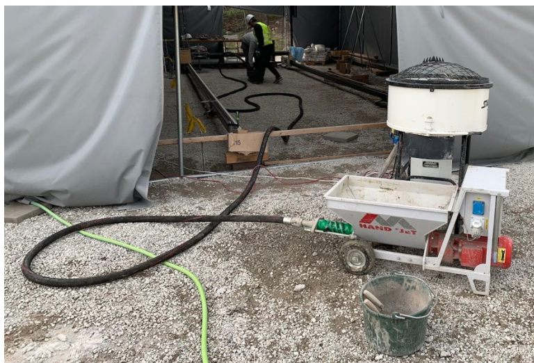
Figur 3.3 Projektets uppställning för blandning och pumpande.
